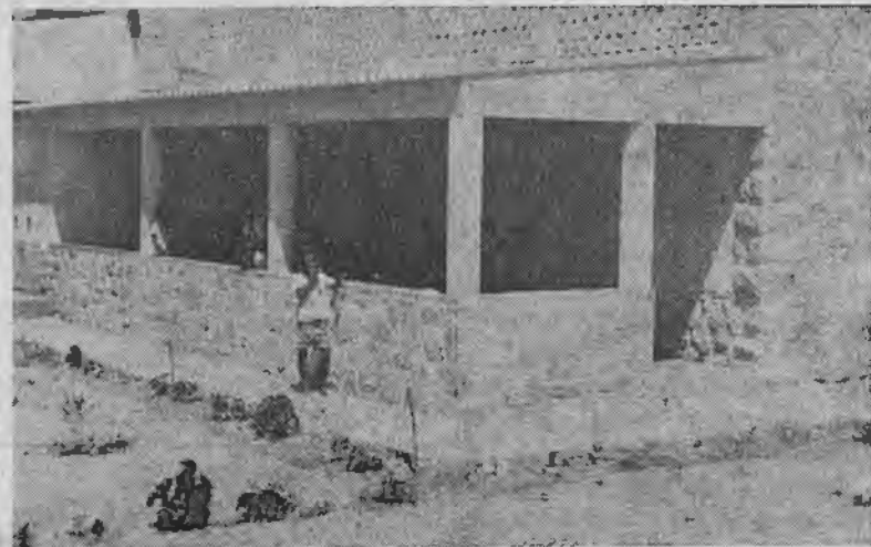
Um recanto da nossa Casa de Benguela — Sala de jogos, onde os rapazes passam os seus tempos livres. Construída nos últimos meses. Ao lado, a dispensa.
